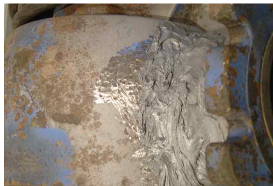
Закреть заплатку слоем Мультиметалла
