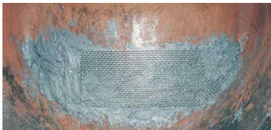
Предварительно обработать отверстие Мультиметаллом и наложить заплатку
