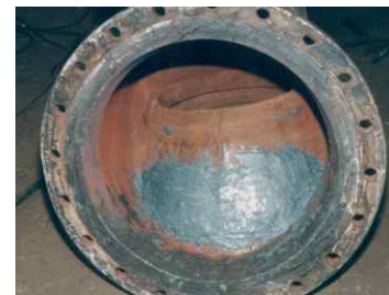
Закреть заплатку слоем Мультиметалла
