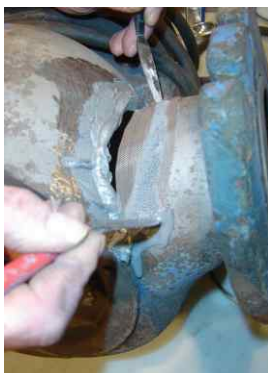
Предварительно обработать отверстие Мультиметаллом и наложить заплатку
